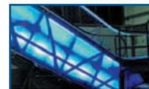
Подсветка несущей конструкции эскалатора
