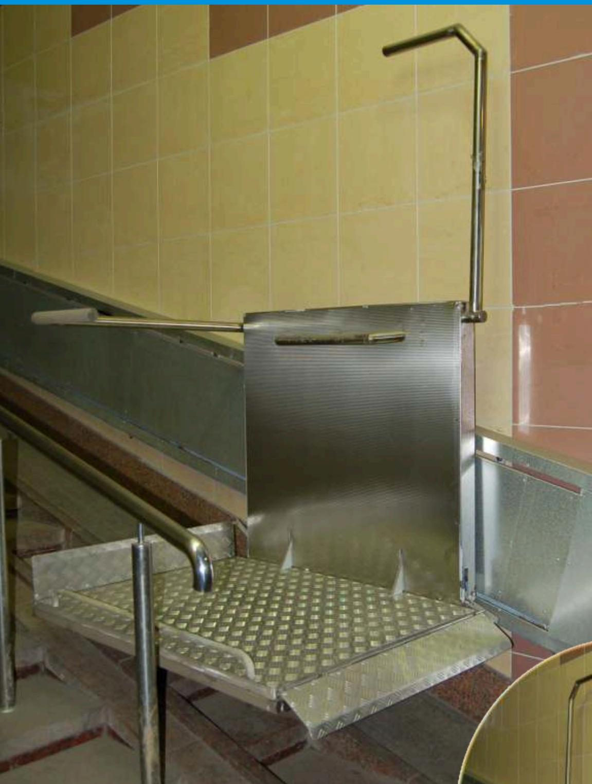
**ИППЛ-1** - наклонный платформенный подъемник, предназначенный для перемещения людей в кресло-колясках с одного уровня на другой вдоль лестничного марш.
